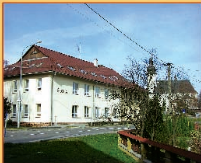
Školní budova v roce 2006
