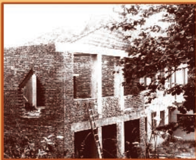
Stavba v letech 1972 až 1976
